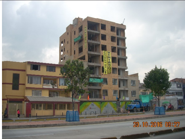
FOTOGRAFIA 1: Vista de pendones instalados en el predio Carrera 10 # 14 – 24 sur sentido Sur –Norte, no se encuentra valla instalada.
