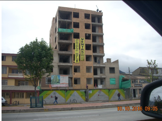
FOTOGRAFIA 1: Vista de valla y pendones instalados en el predio Carrera 10 # 14 – 24 sur sentido Sur -Norte
